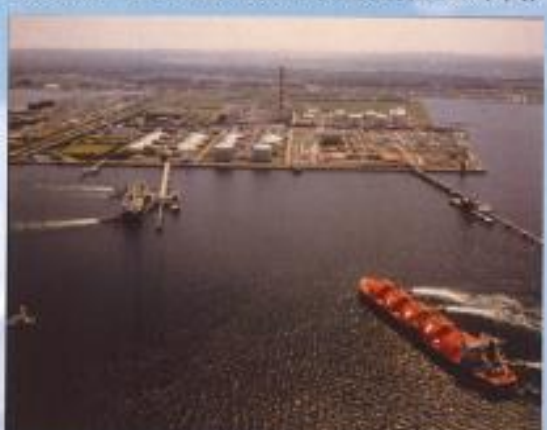
②中袖工場地帯の航空写真(平成初期,長浦)
